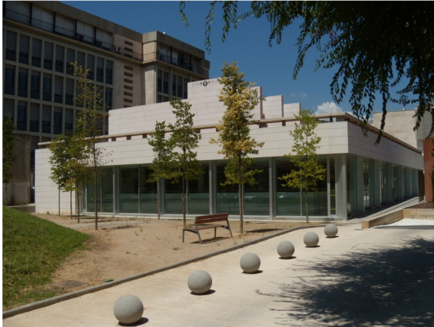
Figura A1.1: Fachada Sur.
