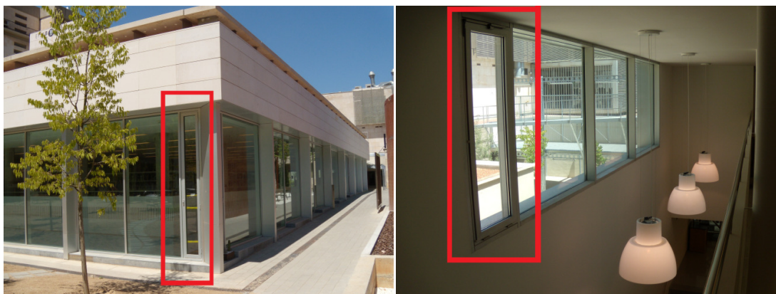
Figura 3.6: Aberturas operables en la planta baja y en la planta primera.
