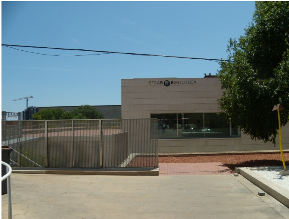
Figura A1.3: Fachada Norte. Vista Av. Diagonal.
