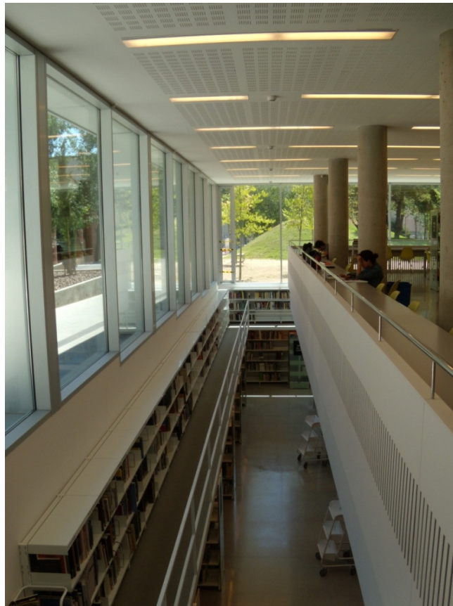
Figura A1.10: Hueco en la losa de la planta baja.
